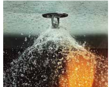
Sprinklersysteme: automatische Aktivierung im Brandfall innerhalb eines Gebäudes für die wirksame Bekämpfung eines Feuers
